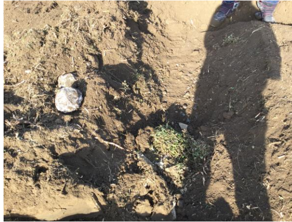
図6. 礫破碎作業施工前と、1回施工後の状態
