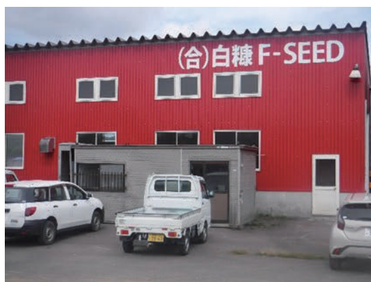
図 1 TMR センター社屋
