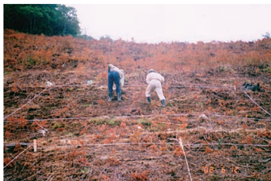
写真2. 前植生を除去した急傾斜地に芝苗を移植している様子
