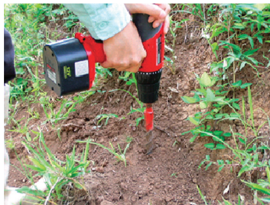
写真 6. 電動ドリルを用いた植穴堀
