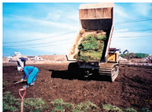
写真 6. 運搬および移植 (平成 11 年 11 月)
