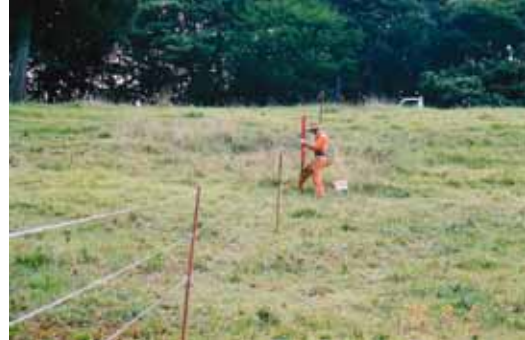
写真 4. 電気牧柵の設置 (平成 14 年 8 月)
