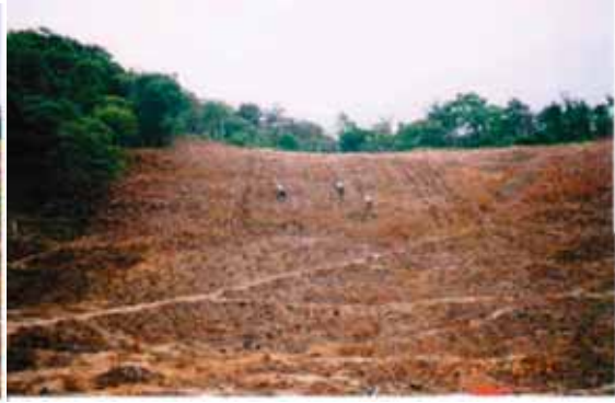
シバの植え付け作業
