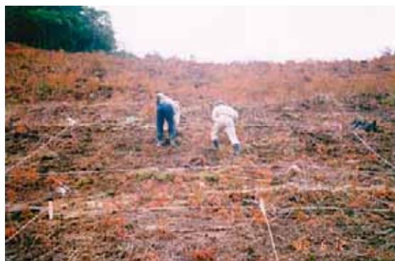
写真2. 前植生を除去した急傾斜地に芝苗を移植している様子
