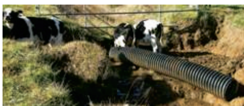
写真4 侵食溝への家畜の進入状況
