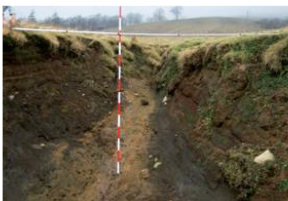
写真1 放牧草地に発生した大規模な土壌侵食
