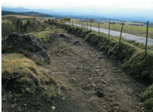
写真1 久住地域の牧柵沿いの侵食状況
