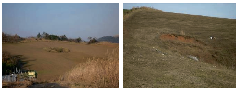
写真 2 圃場内のドリーネ（左）とドリーネ付近で発生した地表面のずり落ち（右）。
