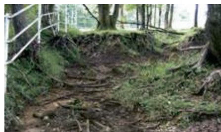
写真5 庇陰林内部の侵食状況
