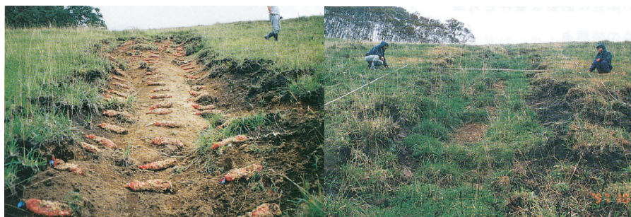
写真3 ガリ侵食地に設置したストーンバック（写真左）と3年後の修復状況（北海道北斗牧場）
