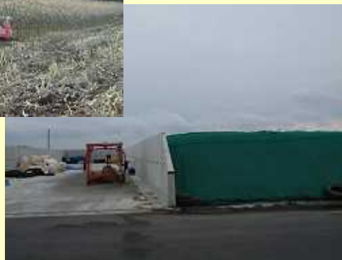
(写真:左)大型バンカーサイロ (道東TMRセンター) サイズ:10m(間口)×50m(奥行き)×2.7m(高さ) =1350m 3
