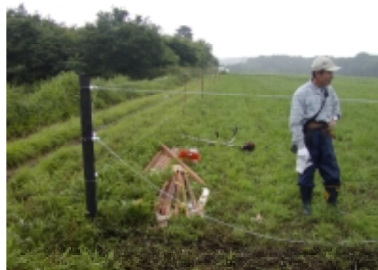
高張力線牧柵の施工・準備
